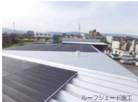
ルーフシード施工
